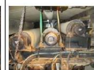
プランマープロックにベアリングを納め替え付け完了
